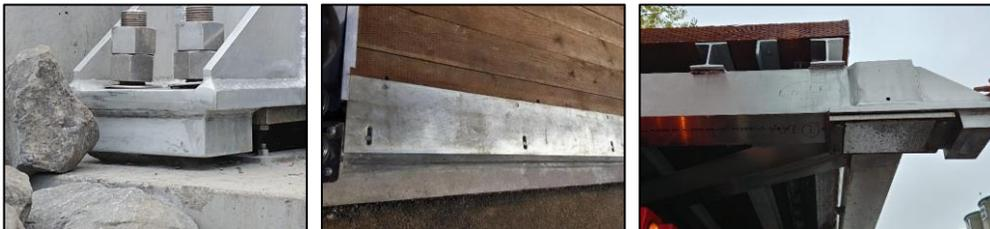
Figure 2: De gauche à droite: les tiges d'ancrage, les joints de dilatation et les appareils d'appui glissants
