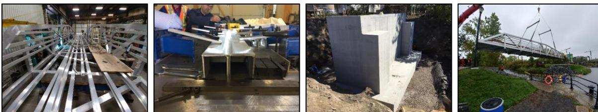
Figure 3: De gauche à droite: l'assemblage à l'usine, tests de soudage par friction malaxage (FSW), culée en béton préfabriquée et levage de la grue
